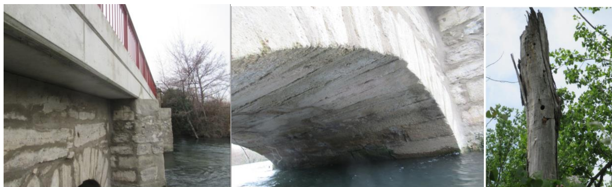
Figure 8 Illustration d'ouvrages d'art (défavorables aux chiroptères, absence de fissures, drain, corniches) et loge de Pics attractives
