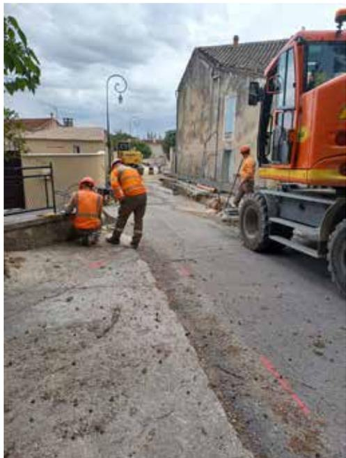
La troisième et dernière phase du chantier de la rue Perrolane est quasiment terminée. Une réouverture de la chaussée va s'avérer nécessaire à l'intersection avec la route de Caumont, car une imperfection a été détectée par le contrôle de l'écoulement par caméra. Le revêtement bitumé de la tranchée devrait être fait lorsque vous lirez le bulletin municipal de décembre.
