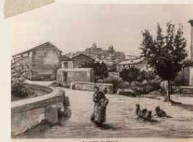
Le pont du Sénot
