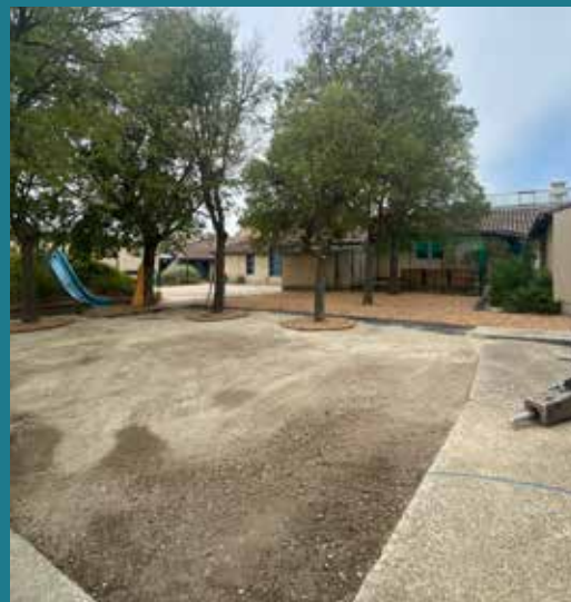
Pendant les travaux
