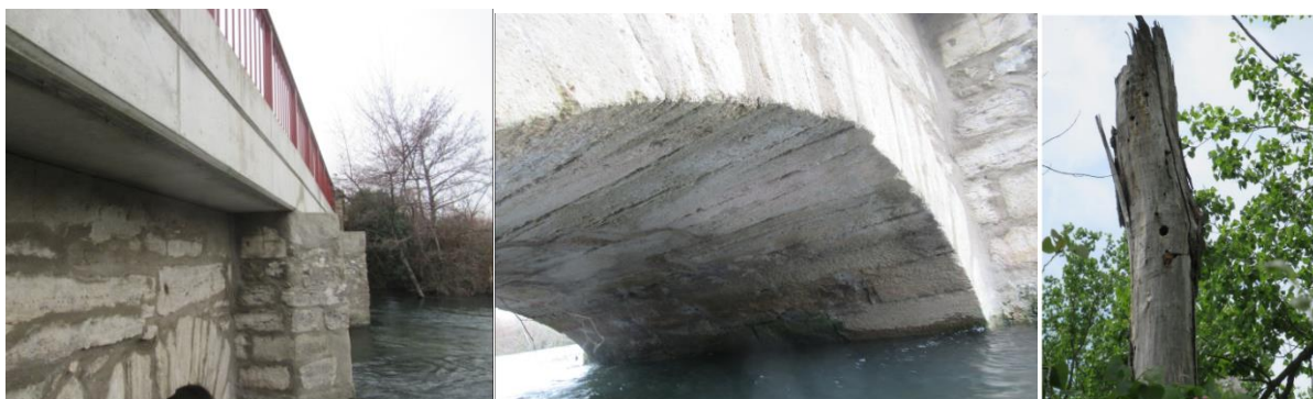
Figure 30 Illustration d'ouvrages d'art (défavorables aux chiroptères, absence de fissures, drain, corniches) et loge de Pics attractives
