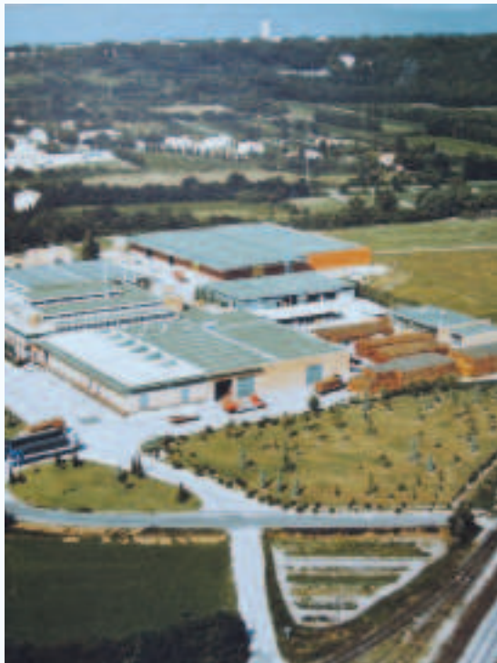
Deux des réalisations majeures de la municipalité Milhaud : l'usine Schweppes au premier plan et au fond le château d'eau (années 70).
